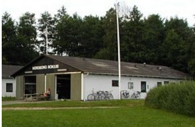
Da byplanen blev ændret i 1974 blev der mulighed for at bygge nyt klubhus hvis vi kunne skaffe penge til det. Der blev udført et stort projekt i 2 etager, men det var klubben ikke i stand til at realisere. Det endte ud med bygningen herover og det stod færdigt i 1977. Nu var der både køkken, baderum og to toiletter!
